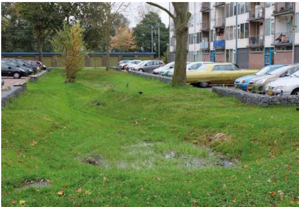
Wadi's vangen het overtollige water op voordat het in de bodem wordt afgevoerd.
